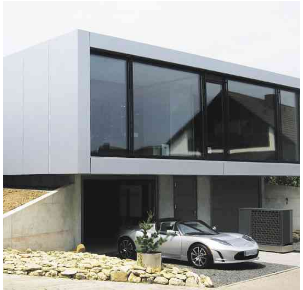
Das Aktivhaus des Architekten Albin Toth. Rechts neben dem elektrisch betriebenen Tesla Roadster fügt sich die Luft-Wasser-Wärmepumpe harmonisch in die Umgebung ein.
